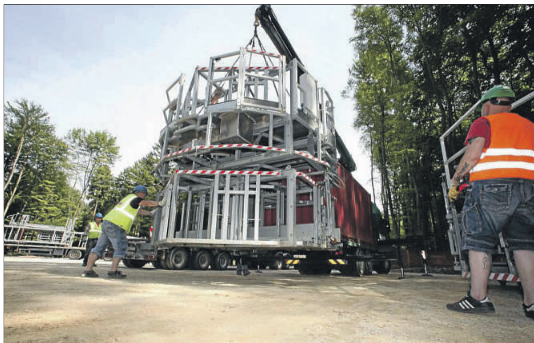
Schweres Gerät: Derzeit werden die Vorbereitungen zum Aufbau des Turmkranes getroffen. Anfang Juni soll er stehen.
