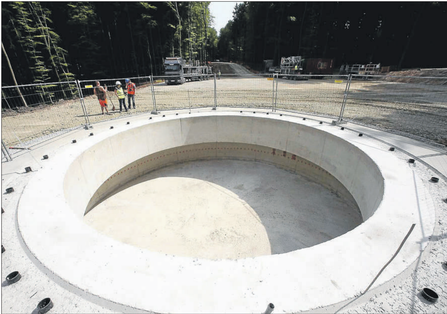
Das Fundament der Energieanlage 4: Die Öffnung hat einen Durchmesser von 11,50 Meter. Durch die Röhren am Rand des Sockelkopfs werden später Stahlseile geführt, die im Fundamentkeller befestigt werden und dem Turm Stabilität geben. Foto: Norbert Müller
